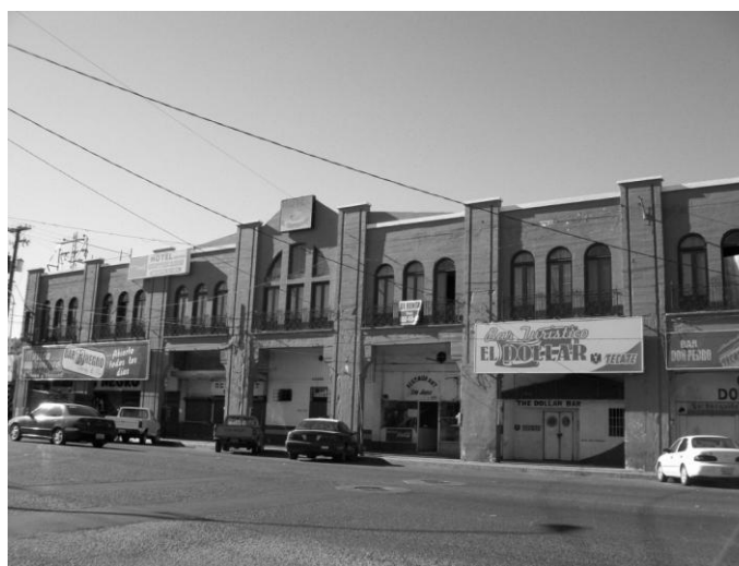
FIG. 20. Hotel Centenario. Fuente: Coordinación del Proyecto Zona Centro.
