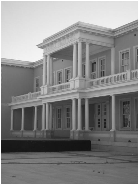
FIG. 19. Edificio de la Antigua Escuela Cuauhtémoc, hoy Casa de la Cultura. Fuente: Coordinación del Proyecto Zona Centro.
